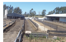
Zona de fossa coberta por grelha em cimento, onde é acumulado e armazenado estrume
